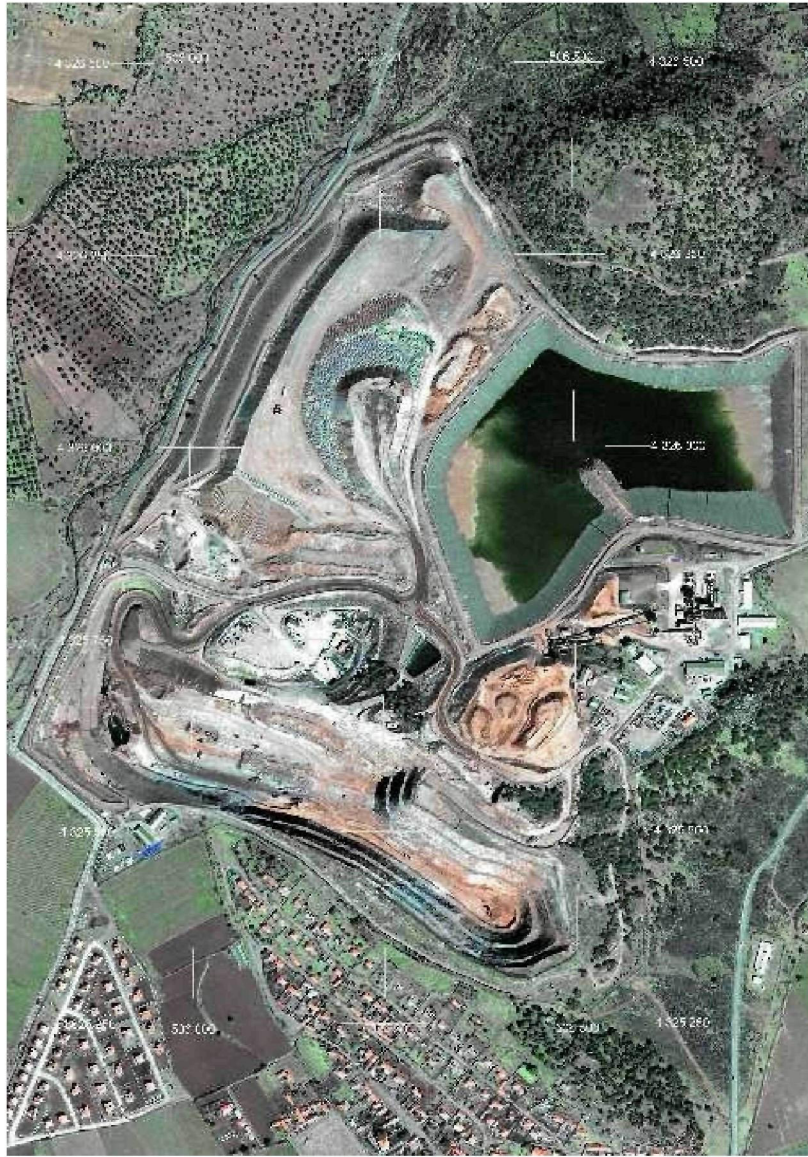
Şekil 1. Ovacık altın madeni ve çevresinin kuşbakışı görünümü.
